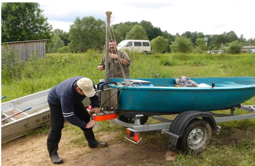
Рисунок 2.10 - Фрагмент монтажа антенны ES70-11 эхолота EY500 на корме весельной лодки
